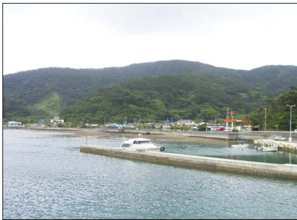
100 瀬相ムラウチ遺跡遠景
